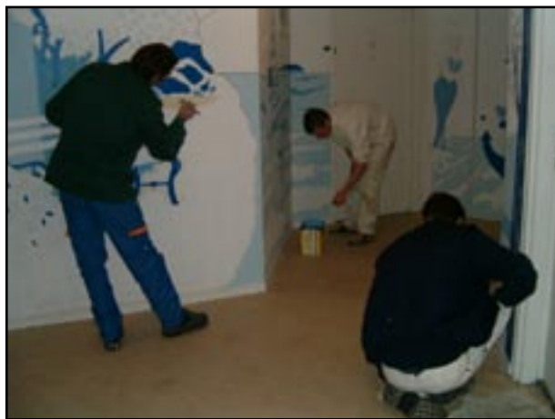
Les ADLC relookent les paliers du bâtiment ME avenue Toumaniantz.
